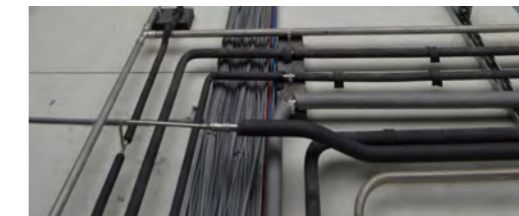
RVS reinigingsleidingen
